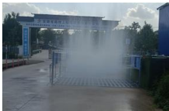
BMTJ-01 标拌和站车辆冲洗平台
