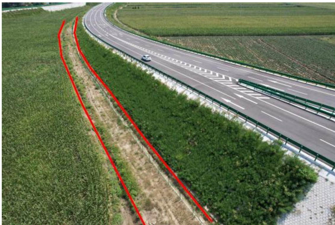
施工便道移交复垦
